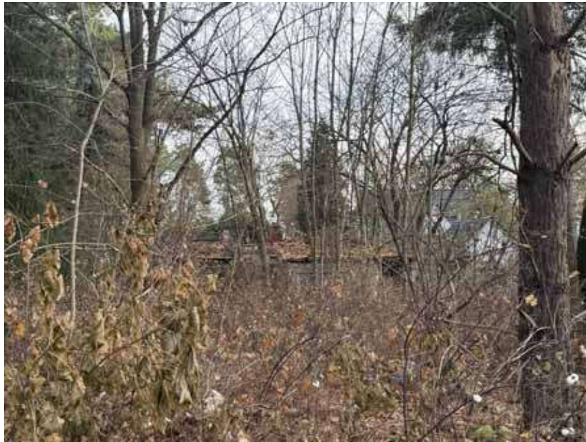
Bild 5: Bungalowruine (Fotozoom von der Straße aus)
