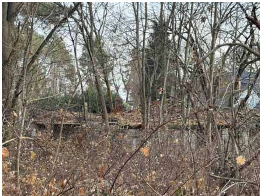
Bild 6: Bungalowruine (Fotozoom von der Straße aus)
