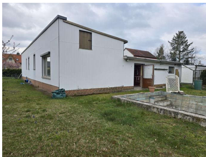
rechte Hausseite / Hausrückseite mit Anbau
