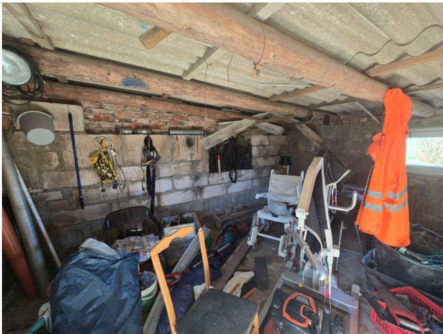
↑ Bild 18: Innenansicht des massiven Schuppens
