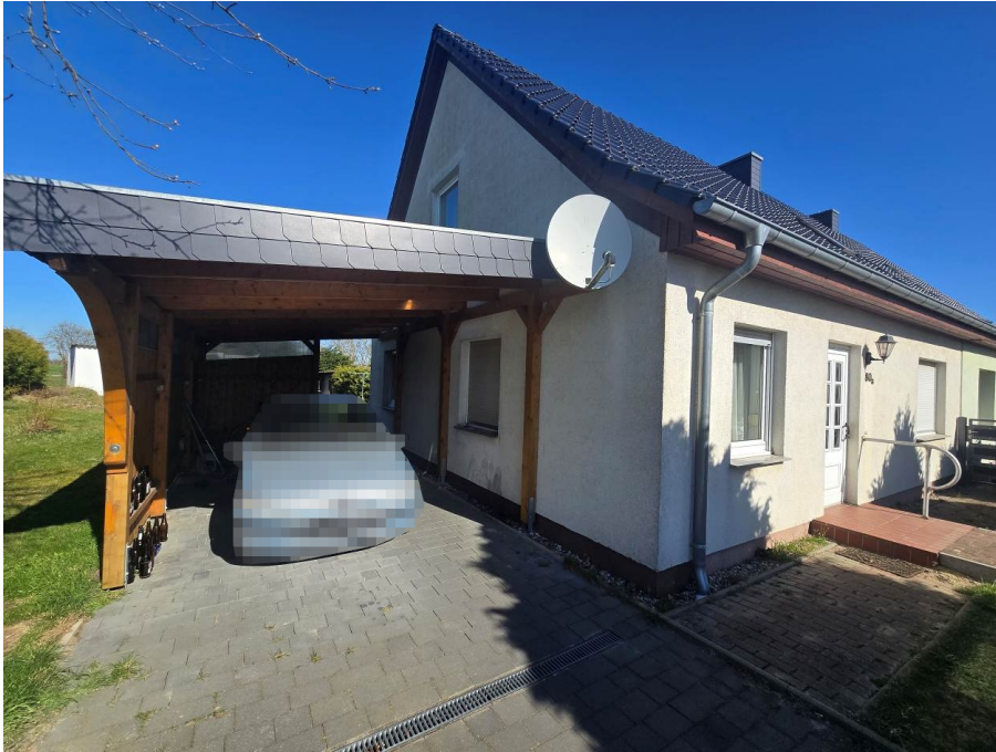
↑ Bild 3: Carport am Westgiebel
