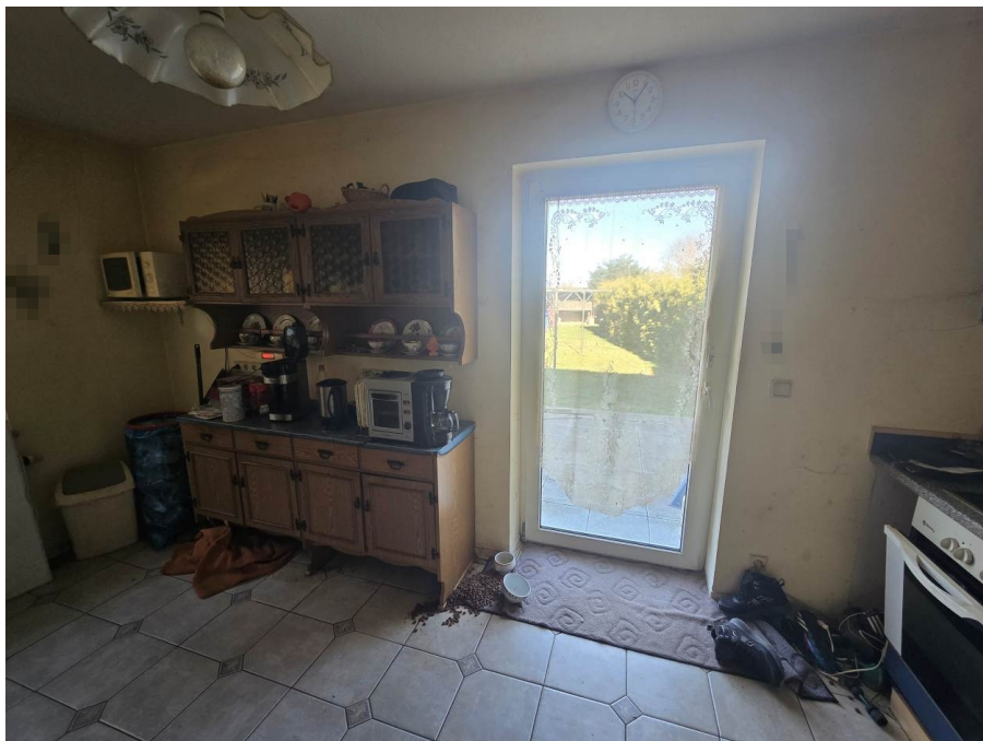
↑ Bild 6: Küche im Erdgeschoss
