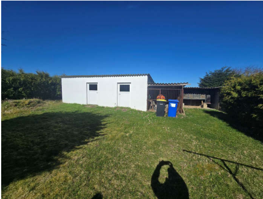
↑ Bild 17: massiver Schuppen
