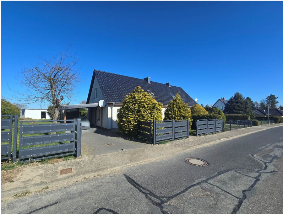
↑ Bild 1: Straßenansicht (Südansicht) des Bewertungsobjektes
