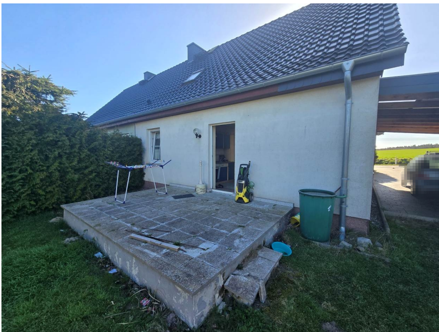
↑ Bild 4: Nordseite mit angebauter Terrasse
