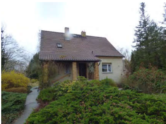
Foto 1: Straßenansicht Wohnhaus – Flurstück 853
