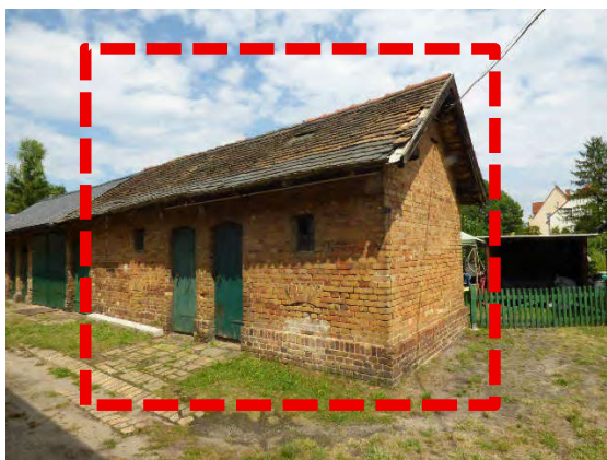
Foto 3: Hofansicht auf Nebengebäude mit anschließenden, nachbarlichen Nebengebäude
