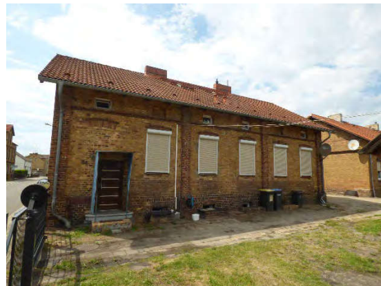
Foto 2: Ansicht Hofseite auf beide Doppelhaushälften und Eingang Nr. 64
