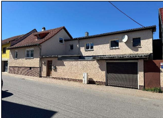
Straßenansicht - Einfamilienhaus & Anbau sowie Garage
