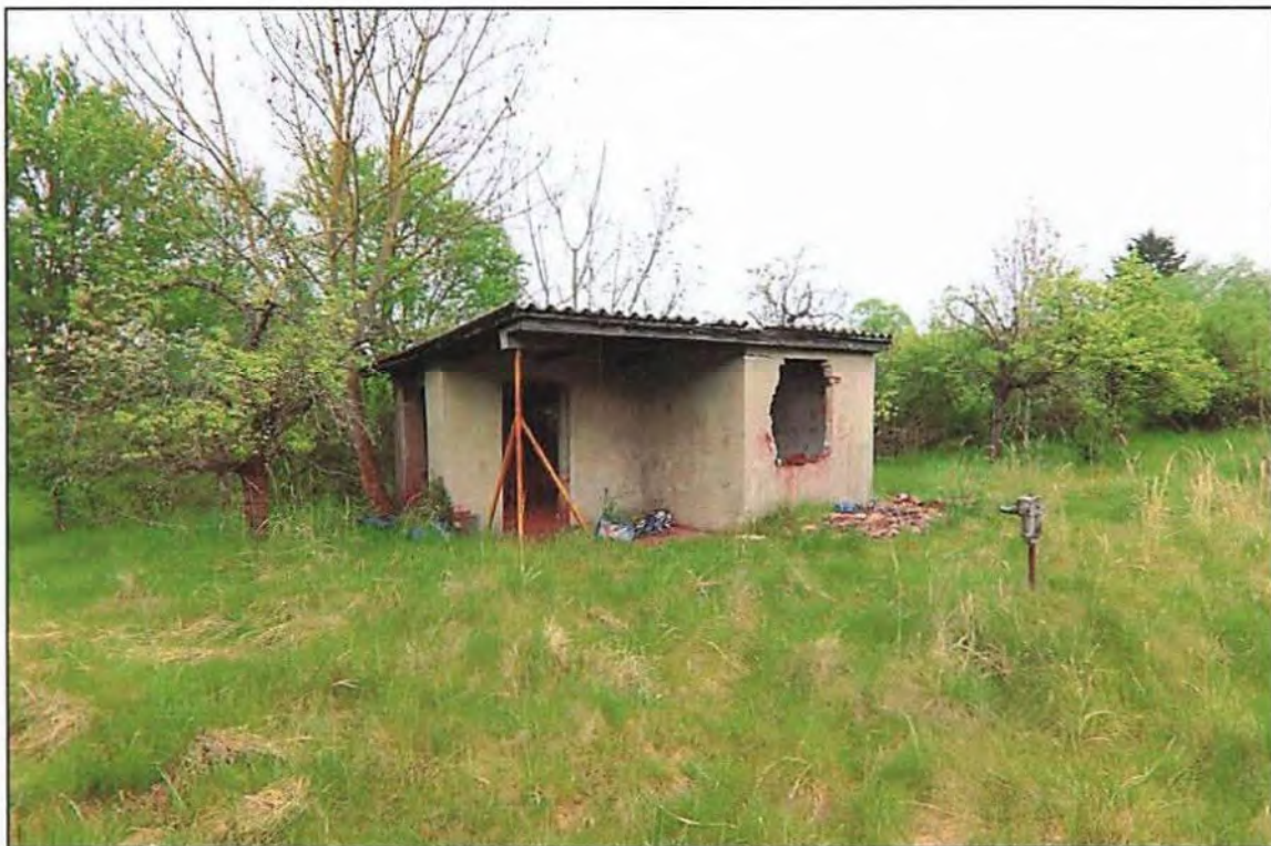
Blick auf den mittleren Teil des Flurstücks sowie auf eine alte Laube, die im Rohbauzustand vorliegt. Die Laube wird in der Verkehrswertermittlung nicht berücksichtigt.
