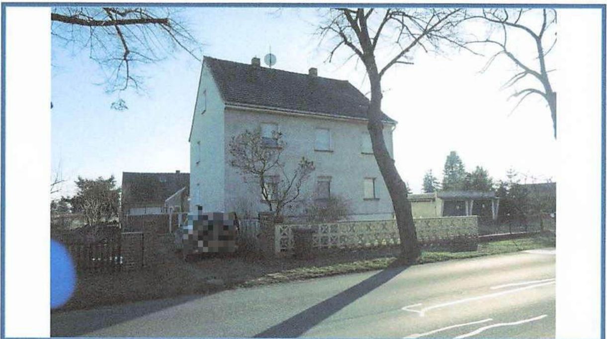
Abbildung 40: Blick in südwestliche Richtung zum Bewertungsobjekt; links das Wohngebäude auf Flurstück 1/1; rechts die Doppelgarage auf Flurstück 1/2
