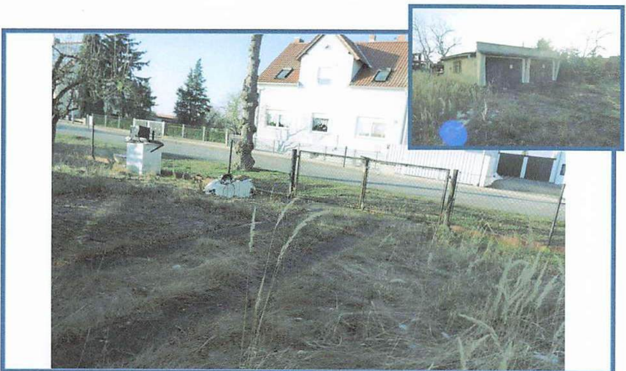
Abbildung 38: Eingangs-/Einfahrtsbereich zur Doppelgarage auf Flurstück 1/2; verwilderte Außenanlagen und Unratablagerungen
