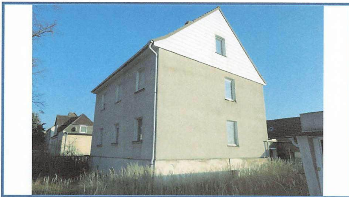
Abbildung 3: Straßenansicht (Nord-West-Ansicht); umliegende Bebauung
