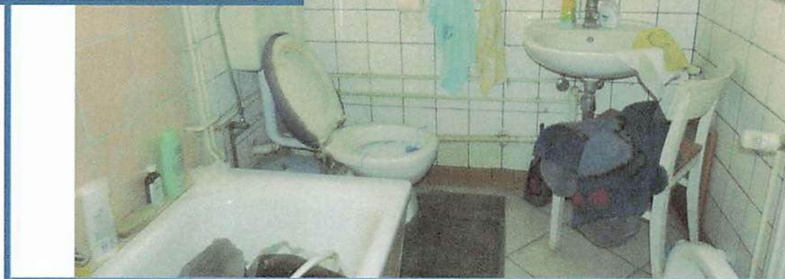
Abbildung 11: Sanitärraum im Erdgeschoss
