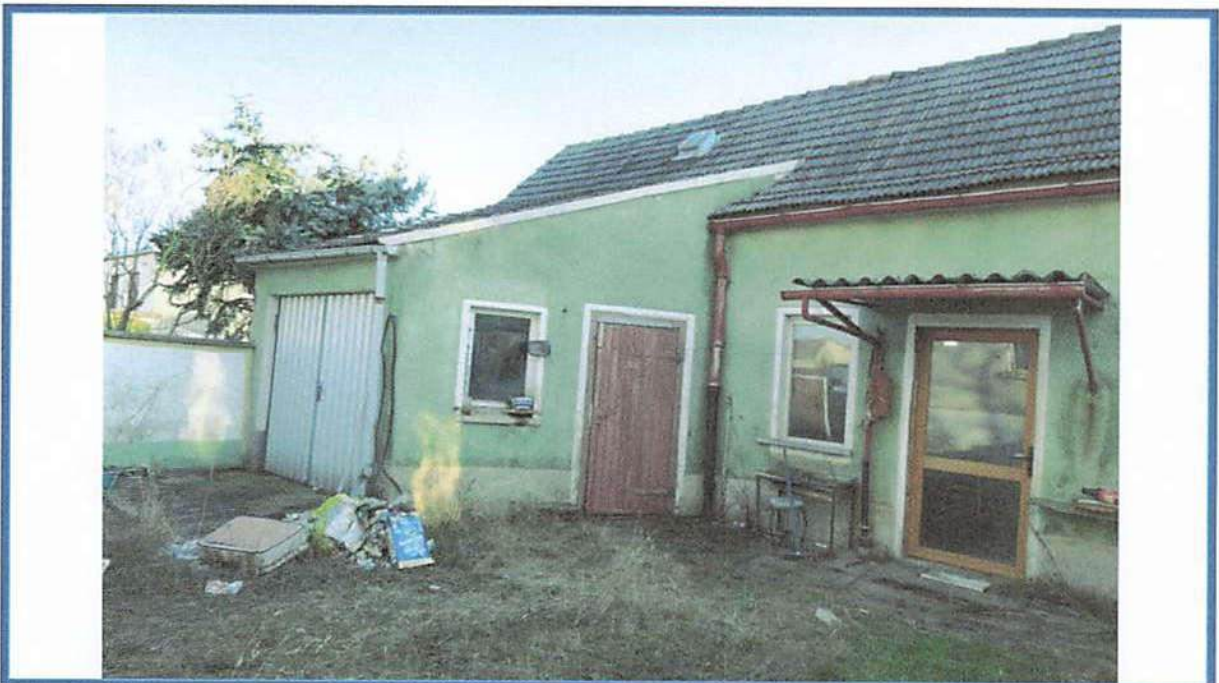
Abbildung 26: Mehrzweckgebäude mit integrierter Garage; verwilderte Außenanlagen im Innenhof (Flurstück 1/1)
