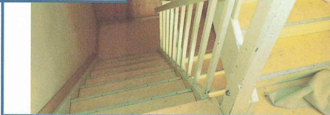
Abbildung 12: Treppenhaus zwischen Erd- und Obergeschoss
