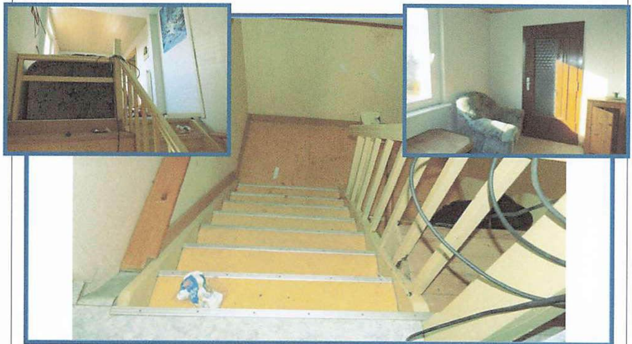
Abbildung 16: Treppenhaus zwischen Ober- und Dachgeschoss; Vorraum im Dachgeschoss
